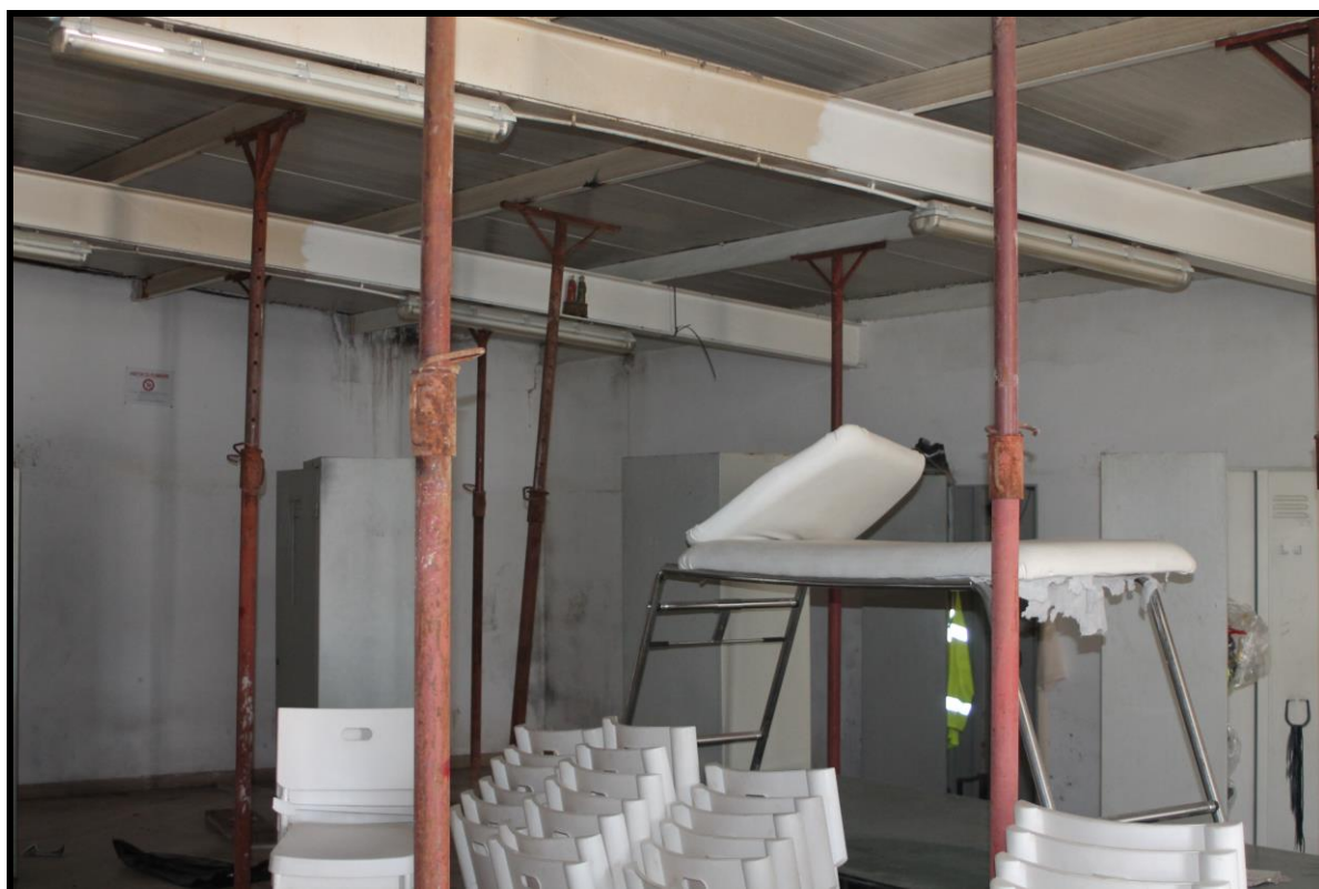
Foto n. 12 vista interna del locale spogliatoio (con puntelli della struttura della tettoia)
