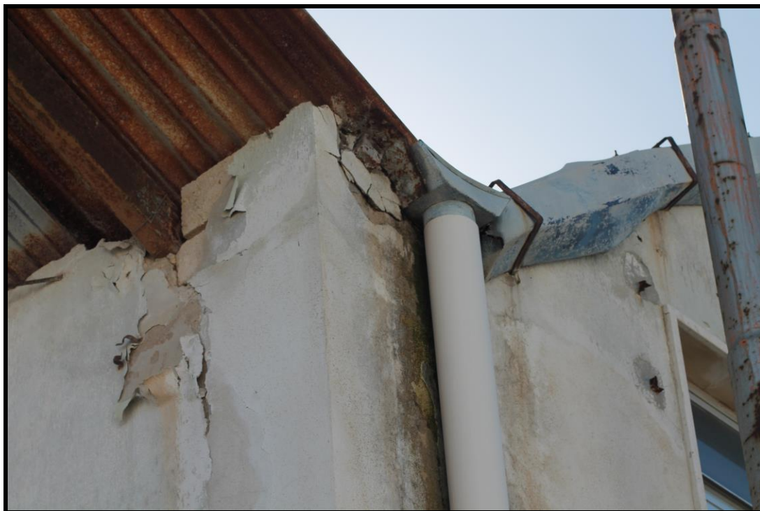
Foto n. 20 particolare dello stato interno di degrado strutturale e di finiture della palazzina uffici su due piani
