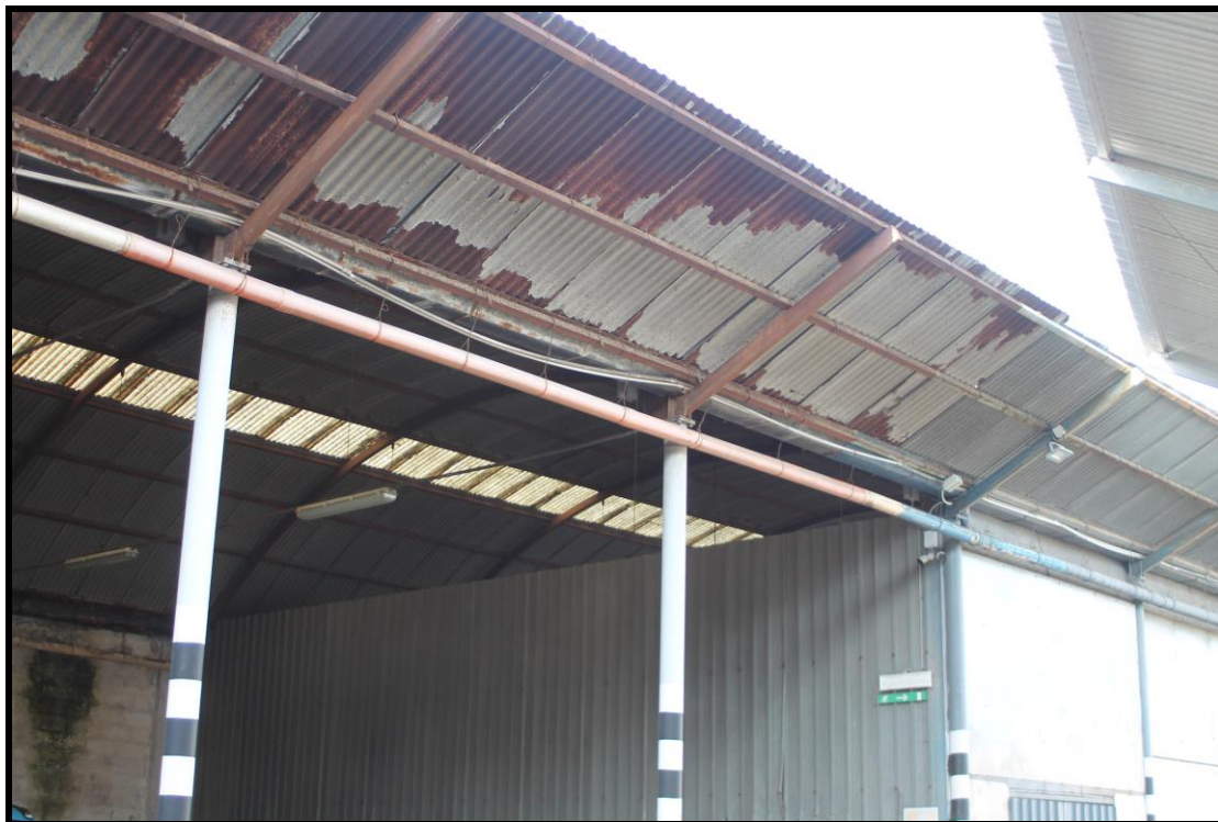
Foto n. 18 particolare dello stato ossidativo della copertura del capannone
