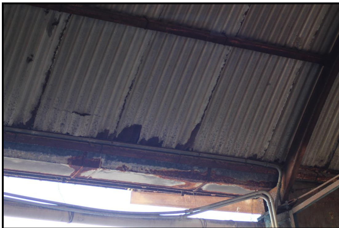
Foto n. 18 particolare dello stato ossidativo della copertura del capannone
